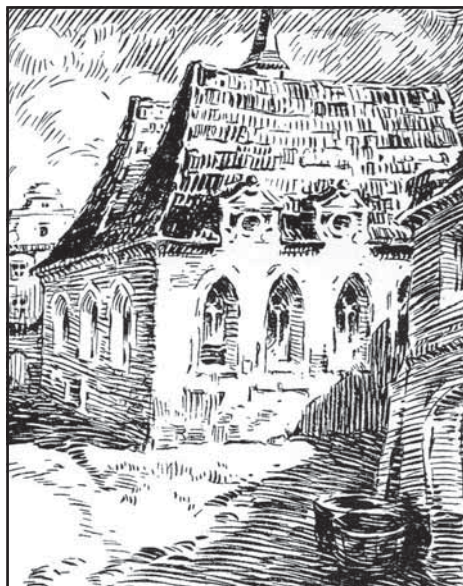
kaple Betlémská v původním stavu před modernizací
