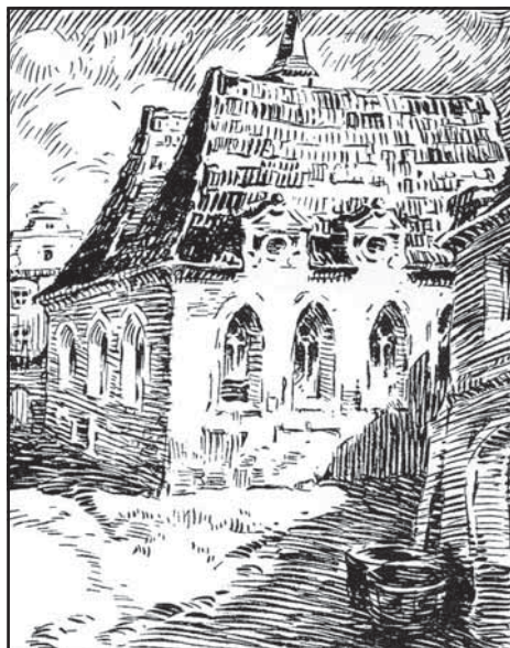
kaple Betlémská v původním stavu před modernizací
