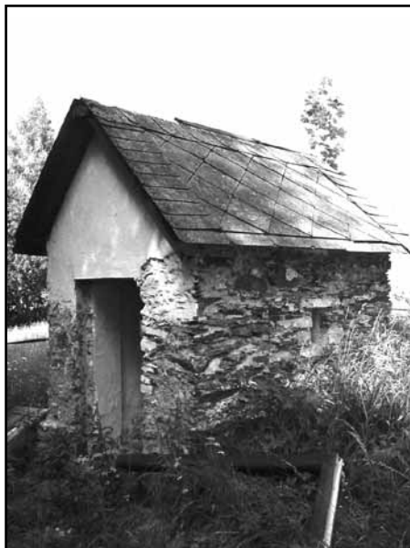
Kaplička před rekonstrukcí
